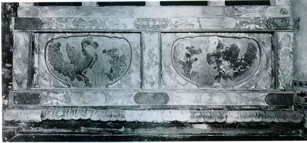
单色图7 西南壇正面（修理前）
