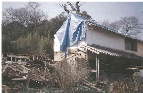
図1 阪神・淡路大震災で被災した土蔵
