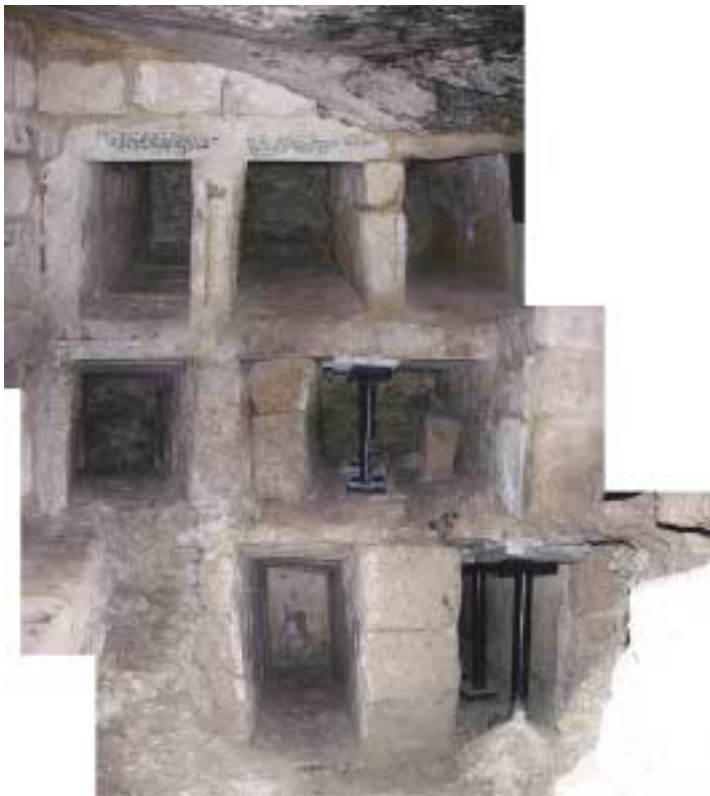
图版32 南壁（修復後）
